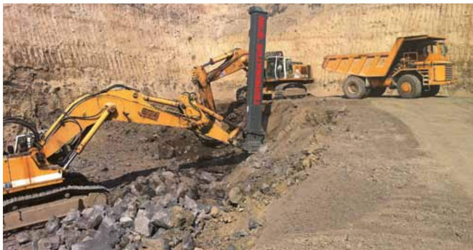
Umstellung: Die Anordnung der Maschinen muss bei der Fallgewichtshammer-Methode geändert werden.
